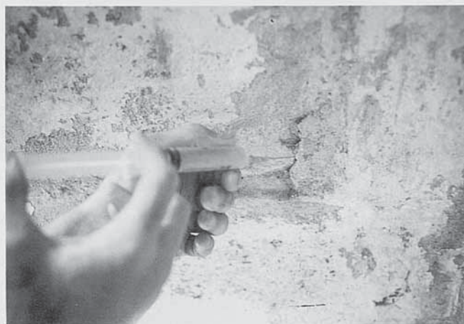
Intervention sur la fresque, injection de colle.
