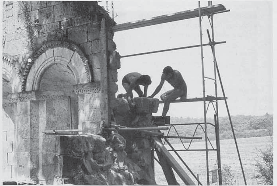
Travaux de restauration.
