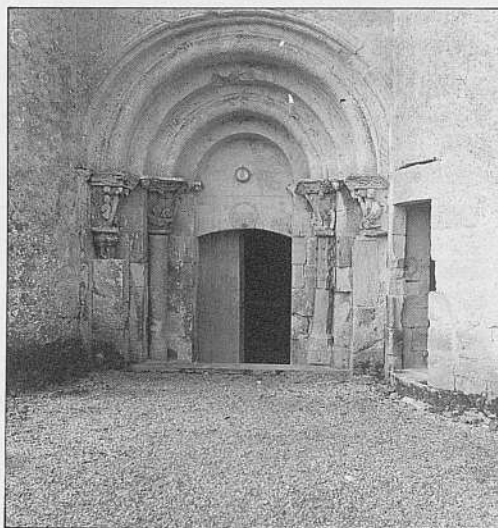
a. Vue du portail de Daubèze avant dégagement ;
