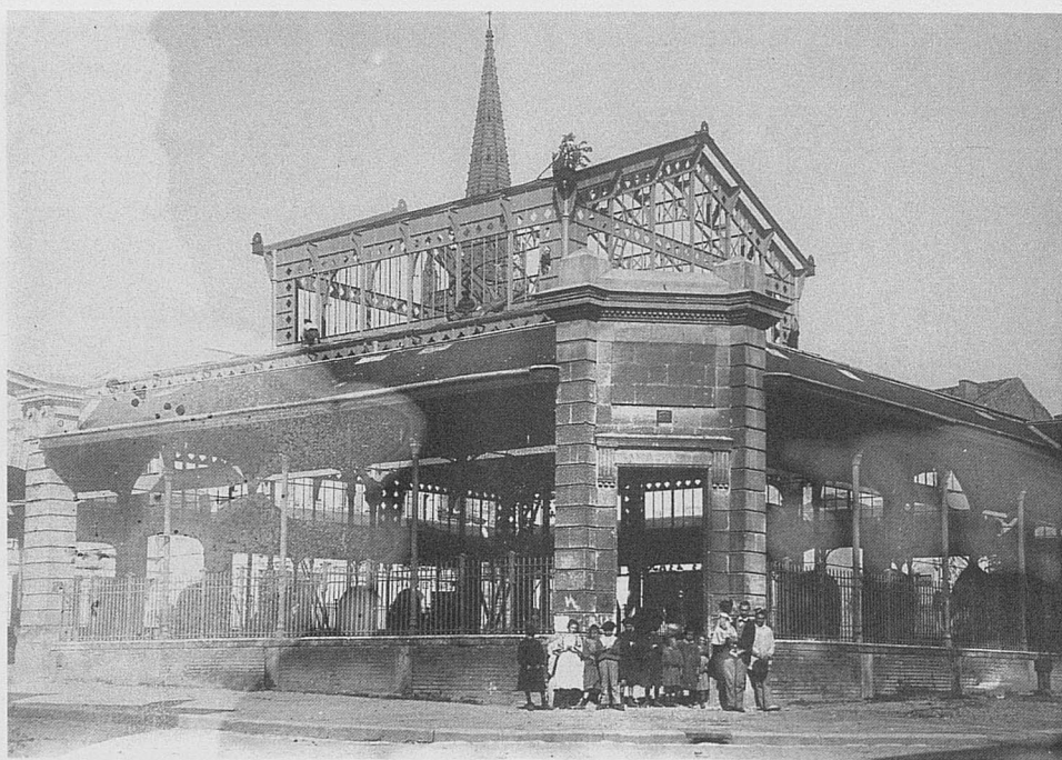
Fig. 5. La charpente métallique est achevée. 1897. (coll. part., archives G.A.H.M.S.).
