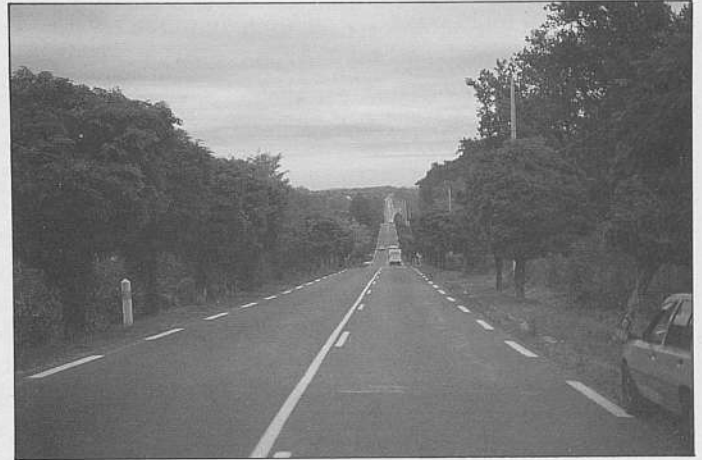
Fig. 6. La côte de Camarsac : la route « alignée » au XVIII e siècle franchit de front les fortes déclivités de la vallée du Gestas.
