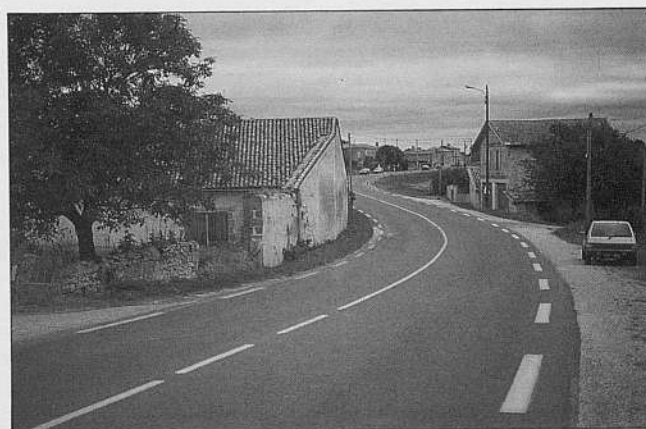
Fig. 9. Virages structurels en S, au débouché de la côte de Camarsac : raccordement de deux tronçons de route. Les maisons constituent ici un autre élément du problème mais on a couramment ce type de tracé sans le voisinage de bâtiments anciens.
