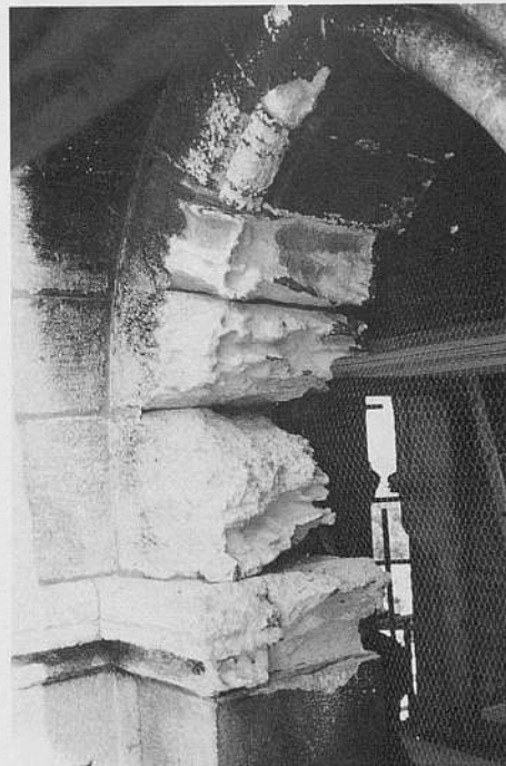
Fig. 12. Sommier, voussoirs, contreclef: état avant travaux.
