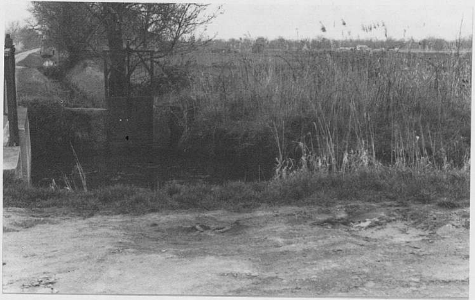
Systèmes d'écluses dans le marais. Au bout du chemin de la Hutte de Rambaud et du Grand Marais, la Grande Jalle, ici au premier plan, reçoit les eaux d'un fossé de ceinture. Le fossé, bordé d'une très petite levée, est fermé par une porte à crémaillère pour éviter que, quand les eaux de la Jalle sont trop hautes, elles ne remontent dans les différents esteys. La Jalle est elle-même munie d'une écluse.
