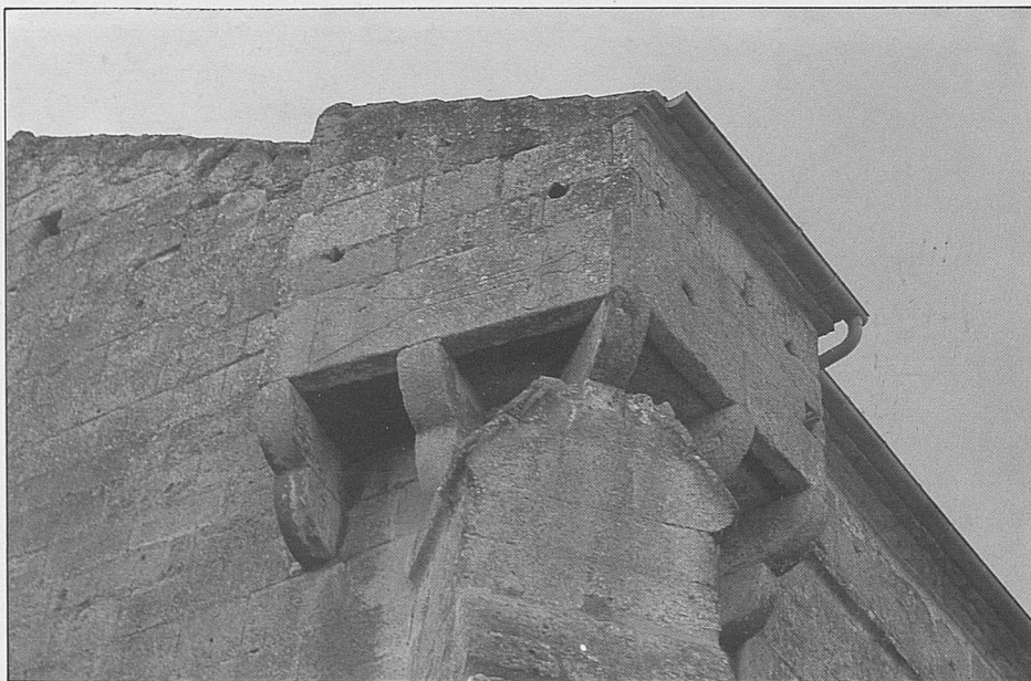
Fig. 12. Echauguette nord-est de l'église de Rimons construite avec une pierre tombale.
