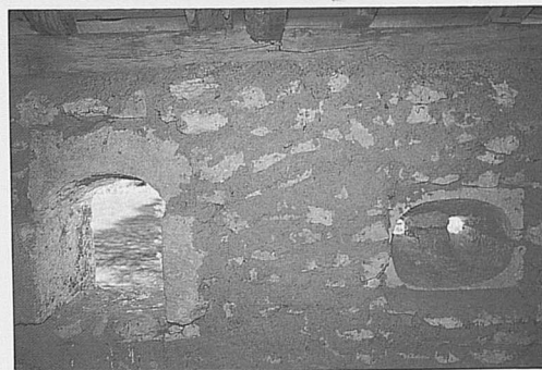
Fig. 6. Meurtrière dans le surhaussement de l'abside de l'église de Bellefond.
