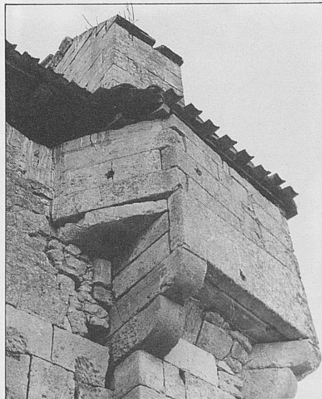
Fig. 11. Echauguette nord-ouest munie de latrines sur l'église de Courpiac.
