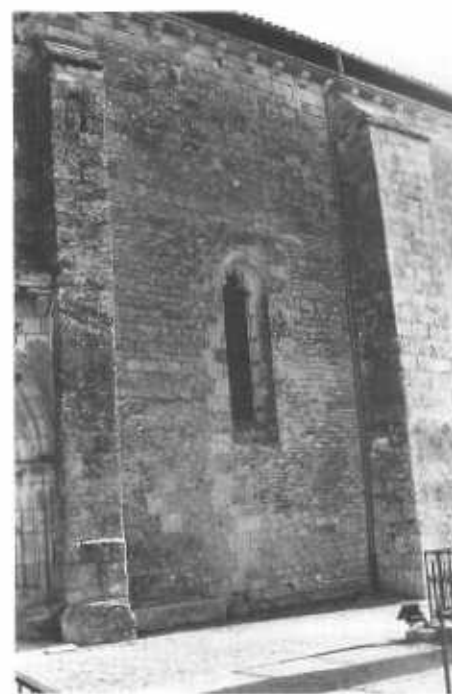
Travée du flanc sud de l'église Saint-Pierre de La Sauve construite en petit appareil antique (cliché J. L. Piat)
