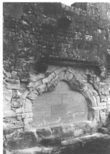
Petit appareil calcaire gallo-romain en réemploi dans un mur de l'abbaye (cliché J. L. Piat)
