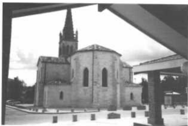
Eglise en cours de restauration.
