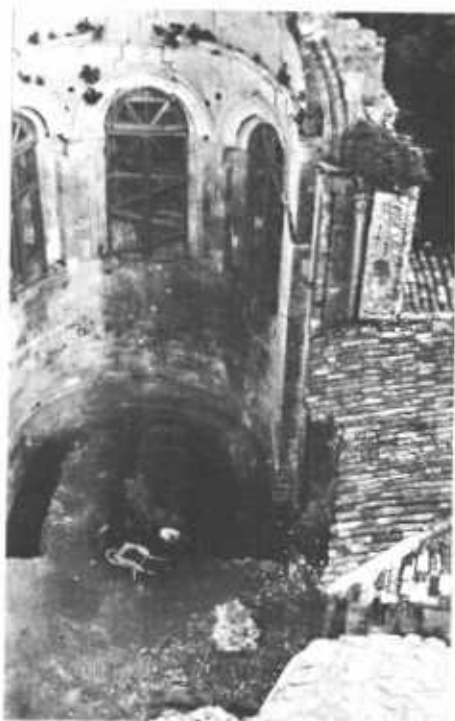
1954 - Restauration de l'abside. Etat des couvertures de l'absidiole sud.
