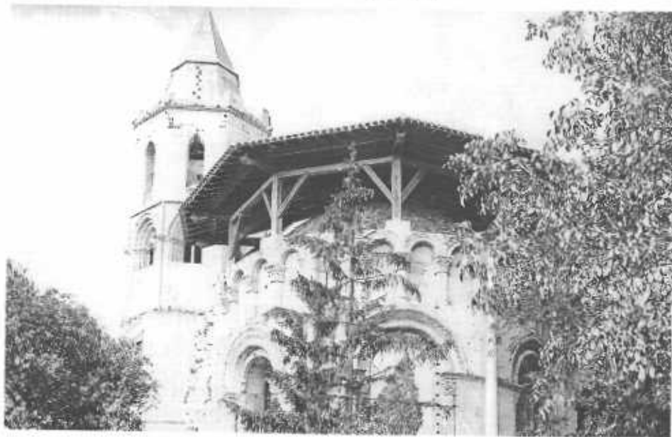
Charpente provisoire posée en 1882 / 84 (diché U. Vergeson).
