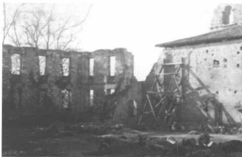
Travaux de recherche du cloître. En arrière plan, l'aile de l'école normale avant démolition (avant 1957).
