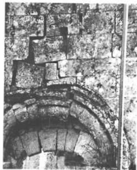
Etat des murs en 1952.
