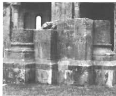
Pile du bas-côté nord restaurée.
