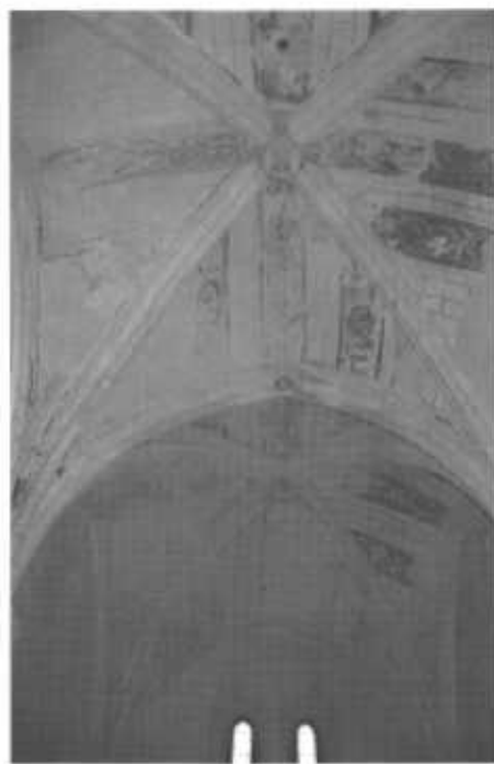
Saint-Emilion, chapelle du Chapitre : les voûtes.
