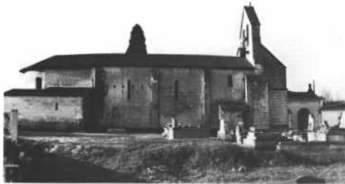
Flanc nord de l'église de Dagnac contre lequel était accolé le bâtiment prioral (cliché J. L. Piat)
